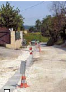
Travaux Chemin des Bergeries
