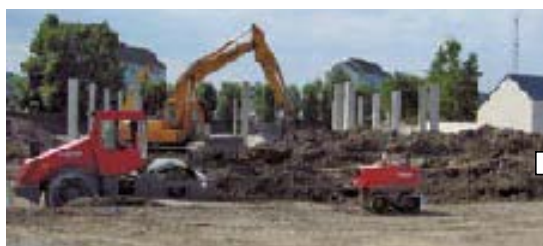
Chantier d'installation du magasin Aldi au Bout-des-Ponts
