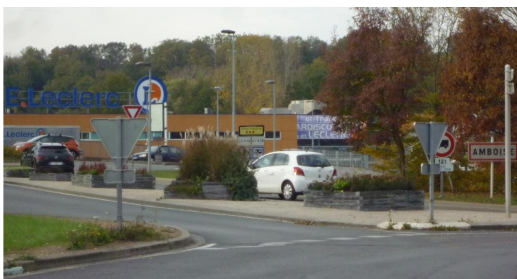
Aménagement existant sur l'avenue L. de Vinci
