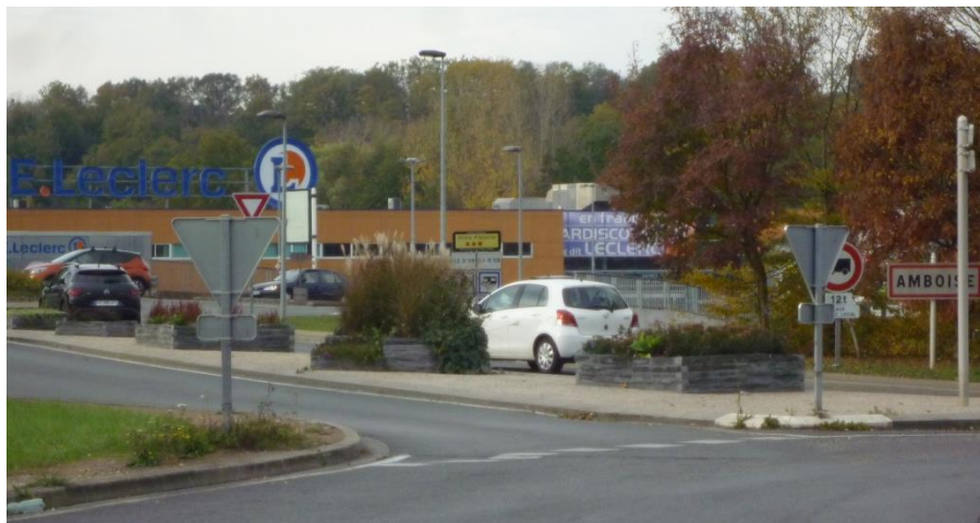
Aménagement existant sur l'avenue L. de Vinci
