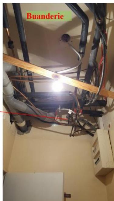
Installation électrique non-conforme, pendante et entremêlée avec l'installation de plomberie devra être reprise.
