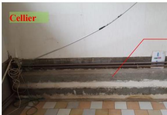
Présence d'amiante : existence d'une gaine fibrociment dans le cellier, courant dans la buanderie, les WC et probablement la salle de bains. Le DTA (Dossier Technique Amiante) du bâtiment ASHAJ stipule que le logement n'a pas fait l'objet d'une recherche d'amiante. Prévoir un diagnostic amiante avant travaux.
