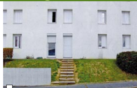
Vue des bâtiments actuels
