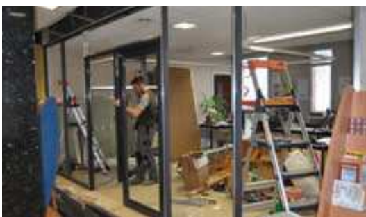
> Les bureaux de l'état civil en travaux
