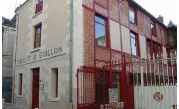
> Après les travaux de rénovation
