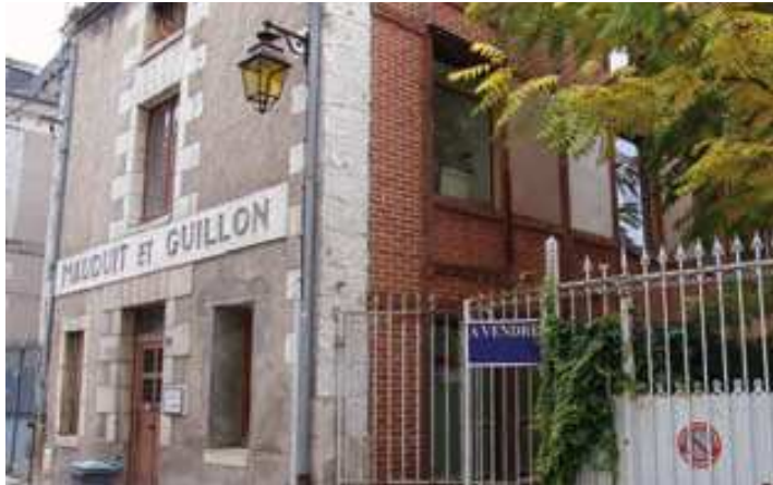
> Avant les travaux de rénovation
