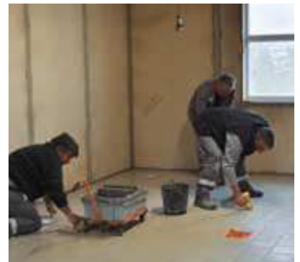
> Travaux du bloc n°3
