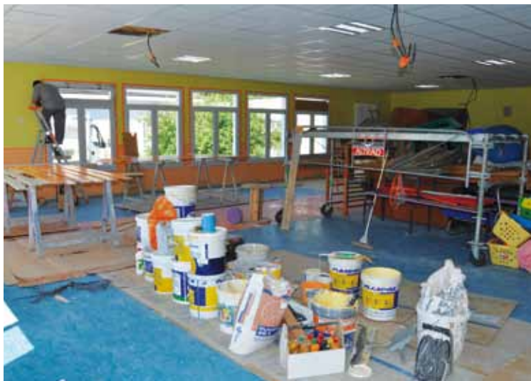
> La salle de motricité de l'école George Sand en travaux
