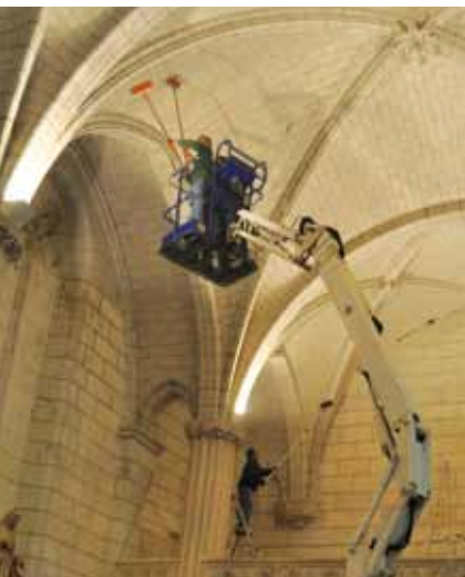
> D'importants moyens ont été déployés pour la restauration de l'église
