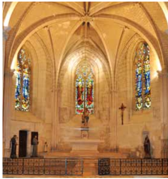
> Après la réparation des voûtes, les vitraux eux aussi ont eu droit à une restauration
