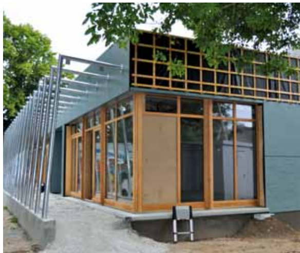
> L'accueil de loisirs se dote d'un bâtiment bioclimatique
