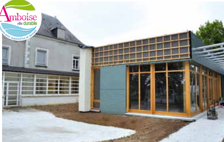
> Accueil de loisirs : le nouveau bâtiment prend forme !
