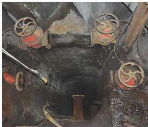
> Dans un puits de 11 mètres, des ouvriers encordés ont remplacé les anciennes canalisations.
