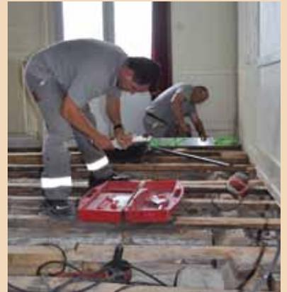
*Cet été, les Services Techniques de la Ville ont réalisé des travaux de réfection du sol d'une salle de classe de CMI, à l'école Ambroise Paré. Après avoir déposé le parquet, les agents l'ont remplacé par des dalles de copeaux pressés sur lesquelles ils ont posé un revêtement en PVC acoustique. Le bureau attendant a également fait l'objet de travaux de remise en état du sol, la fenêtre du bureau et les placards de rangement ont été changés.*
