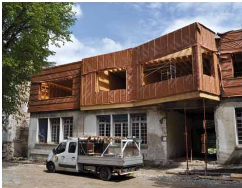
> Les travaux avancent à grands pas et déjà nous pouvons voir l'ampleur des changements. Tandis que le nouveau bâtiment émerge, les murs extérieurs de l'étage sur la partie existante sont posés et l'étanchéité de cette partie réalisée. L'isolation de la maison de maître est désormais terminée. Sur l'extension, la cage d'ascenseur est en cours de réalisation.
