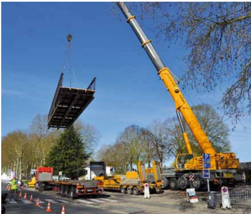
> Début de la manœuvre : une passerelle de 20 tonnes "dans les airs".
