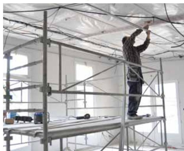
> Depuis fin mars, les travaux d'aménagement de l'intérieur se peaufinent ; doublage, montage de cloisons, plomberie, électricité, chape et pose des carrelages. Le bardage extérieur est quant à lui terminé depuis le mois d'avril. L'ouverture du bâtiment est prévue mi-juillet.
