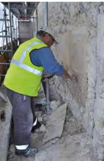
> Travaux de ravalement assurés par les maçons de la Ville.
