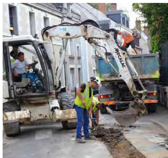
> Première phase des travaux dans la partie ouest de la rue Rabelais.
