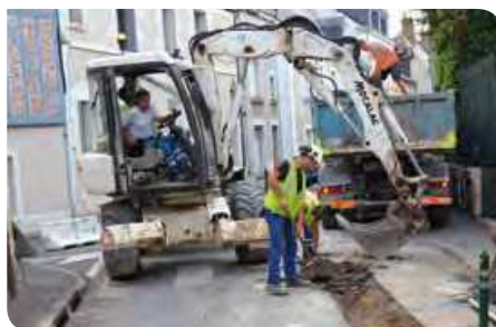
Travaux sur le réseau d'eau potable
