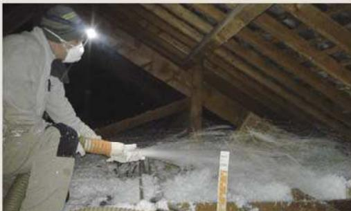
> Isolation des combles de l'école Jules Ferry par projection de ouate de cellulose.
