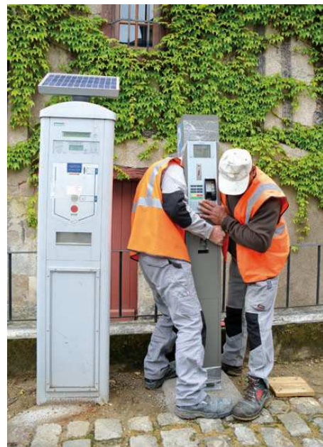
> Installation des nouveaux horodateurs.
