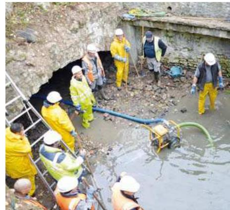
La restauration de l'ouvrage a donc débuté à la mi-octobre pour une durée de deux mois environ. Il s'agit de démonter totalement l'ouvrage, puis de le reconstruire avec des éléments neufs. Ce chantier a nécessité d'assécher le tronçon de la rivière Amasse, au moyen d'un batardeau placé en amont. Les eaux ont été déviées vers le bras secondaire et restituées en aval de l'ouvrage, dans la section recouverte du cours d'eau.
