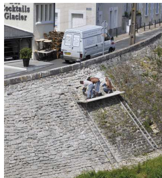
Restauration des perrés de l'Île d'Or
