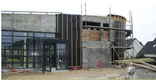
La médiathèque en construction : le 8 avril 2010
