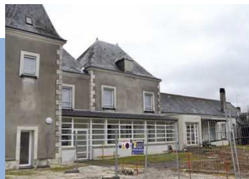
Construction d'un nouveau bâtiment
