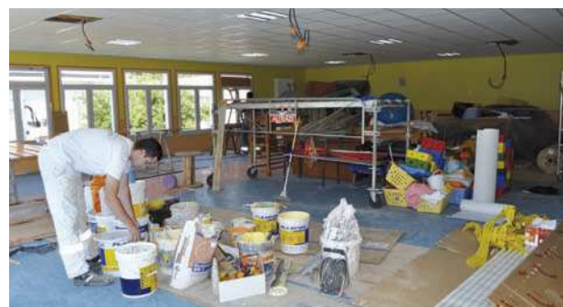
Travaux à l'école maternelle George Sand
