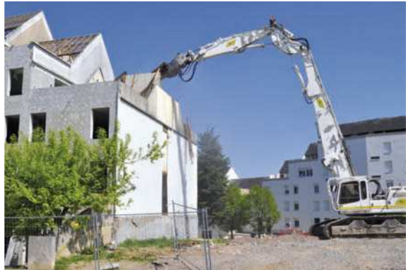
Démolition d'un bâtiment quartier de la Verrerie
